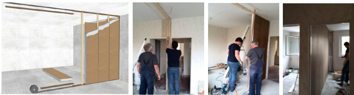
Bild 2: Wohnungstyp „P2“ wird mit Paneelsystem „C3 Technologies“ (TRL 5) nachgerüstet, ca. 1h Montagezeit (ohne Raumtemperierung)
