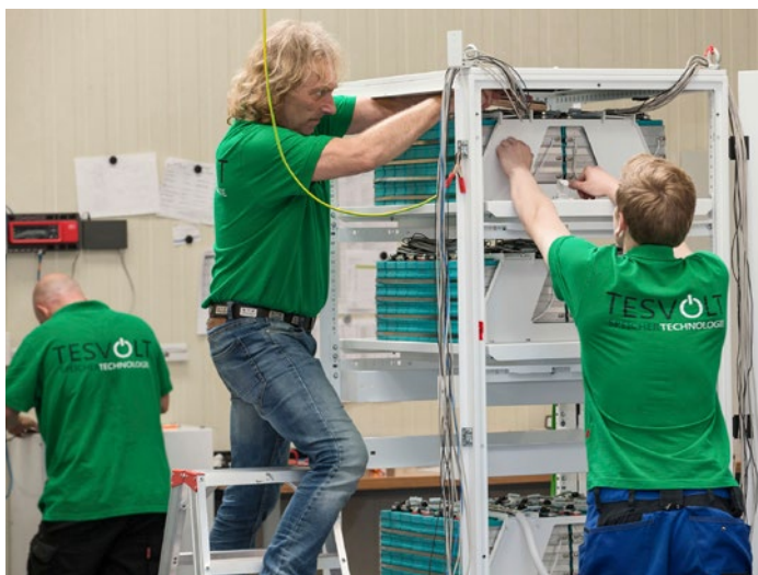
Tesvolt liefert nicht nur regional, sondern weltweit: Ein Gewerbespeicher wird für die Reise nach Ruanda zusammengeschraubt.
