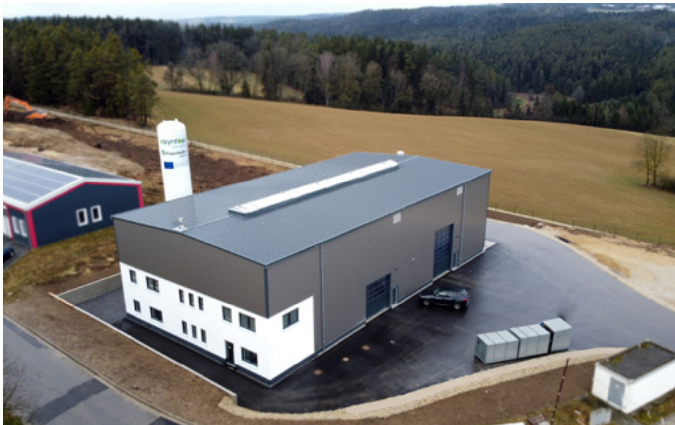
Außenansicht der TCR® Technikumshalle für das TO SYN FUEL Projekt im Markt Hohenburg, Landkreis Amberg Sulzbach. Quelle: Fraunhofer UMSICHT
