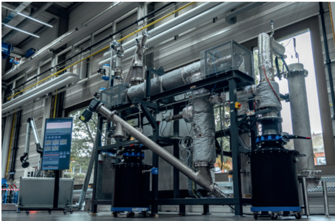
TCR® 30 Technikumsanlage Quelle: Fraunhofer UMSICHT
